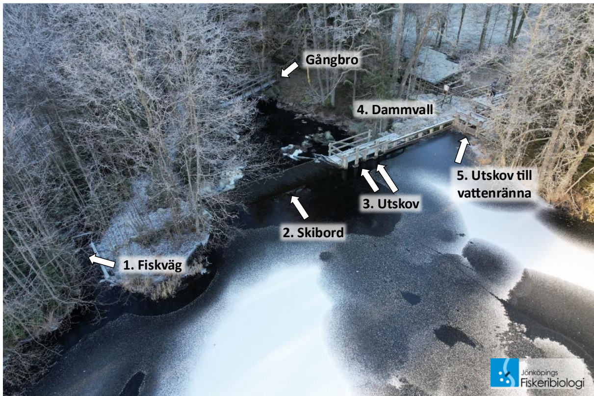
Figur 3. Beskrivning av fiskvägen och dammen vid Jära vattensåg.
